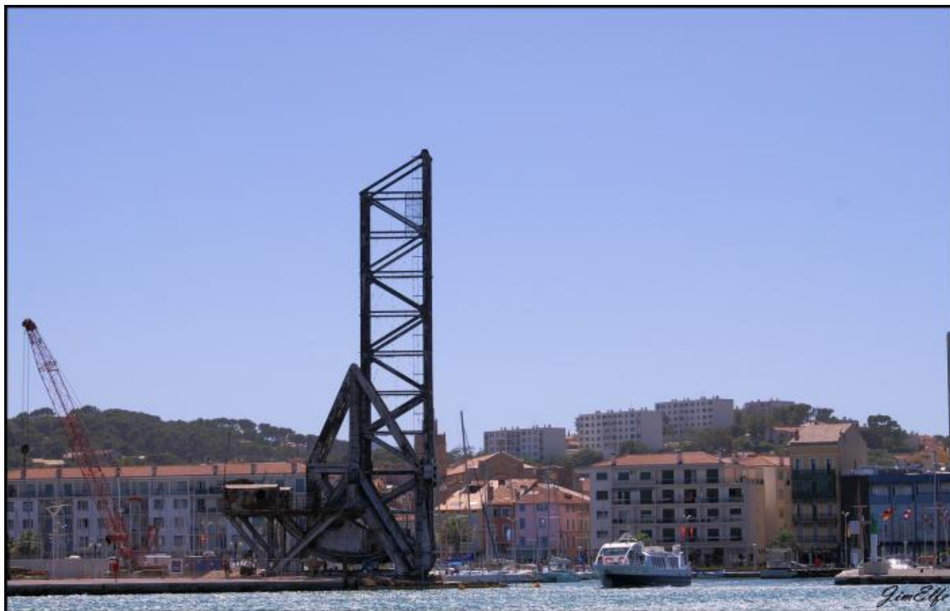
Pont transbordeur, ou pont levant, de La Seyne sur Mer. Utilisé de 1920 à 1986 pour permettre le passage des trains vers les chantiers navals. Il est aujourd'hui équipé d'un ascenseur amenant le public au belvédère situé à 40 mètres de hauteur, offrant un point de vue unique sur la rade de Toulon.
