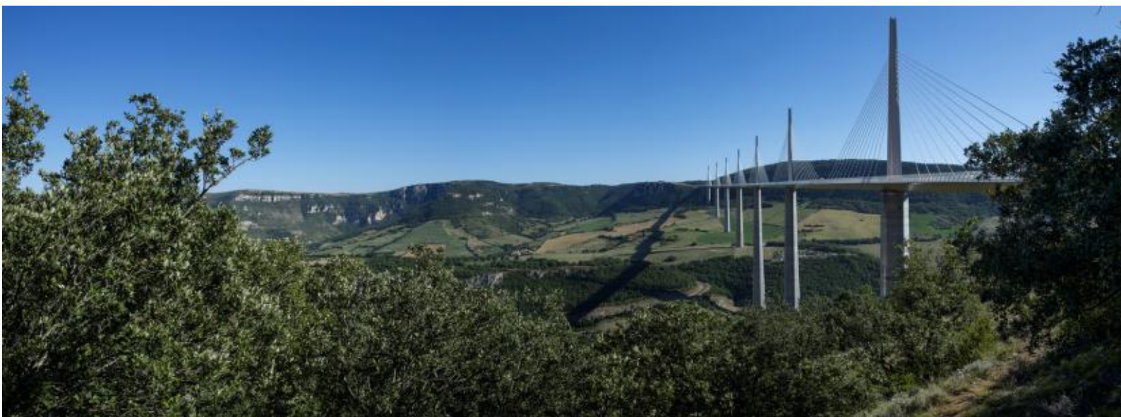
Viaduc de Millau. Il franchit la vallée du Tarn, sur une longueur de 2460 mètres, et un surplomb de 270 mètres au point plus haut. Reliant le Causse Rouge et le Causse du Larzac, il porte l'autoroute A75. Il a été mis en service en 2004
